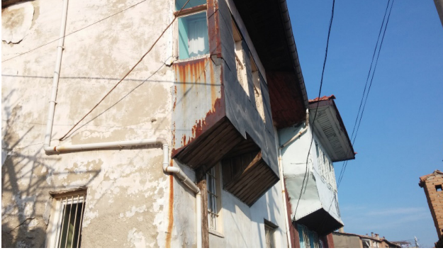
Resim 13. Zemin katta pencere oluşumuna göre biçimlenmiş çıkma (Kasım 2014).
