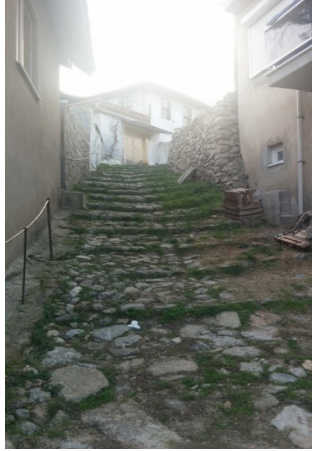
Resim 4. Ortaya doğru eğimli, basamaklı özgün taş döşeme (Kasım 2014).
