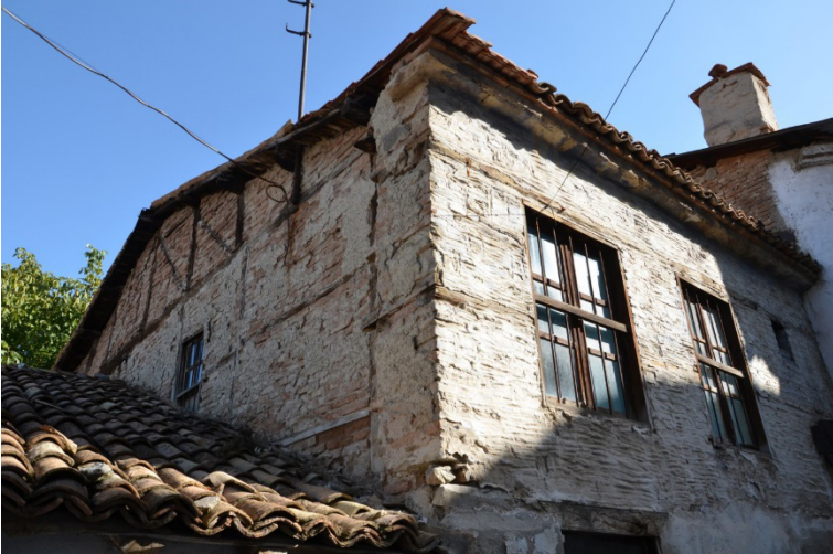
Resim 8. Yapım tekniği örneği (Ekim 2014).
