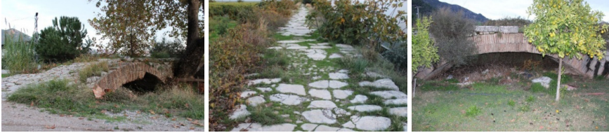
Foto: 8, 9, 10: Kırkgöz Köprüsü (Kasım, 2023)
