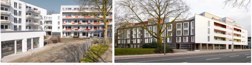
Şekil 19. Yapının cephe görünüşleri (Url 7, 2016)
