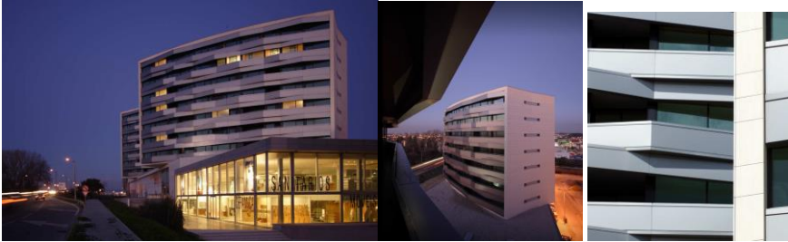
Şekil 21. Yapının cephe görünüşleri (Url 8, 2007)
