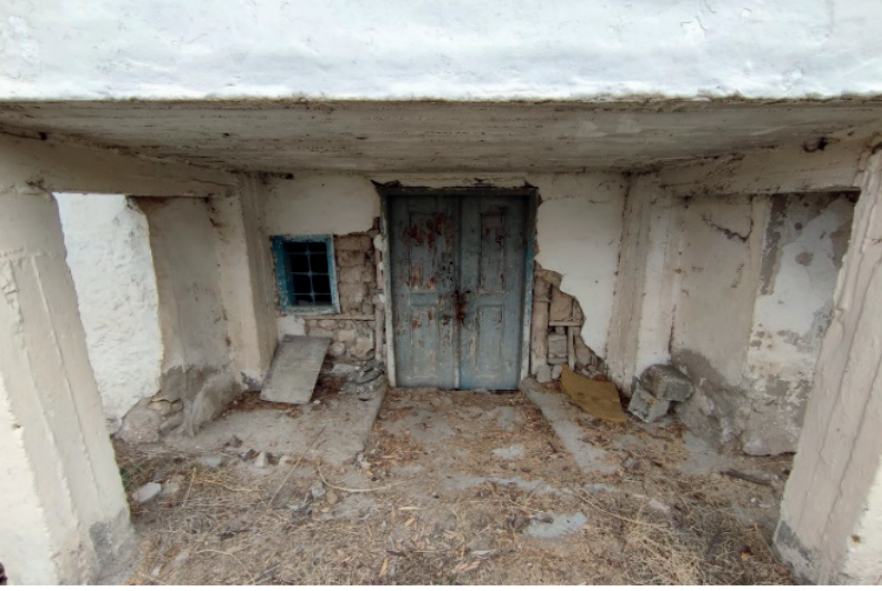
Şekil 10. Zemin Kat Giriş Kapısı Görünüşü (Özel arşiv)
