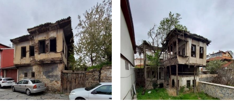
Őekil 12. ve 13. 8050 ada 8 parsel ve 8051 ada 2 parsel zerindeki geleneksel tescilli konutlar
