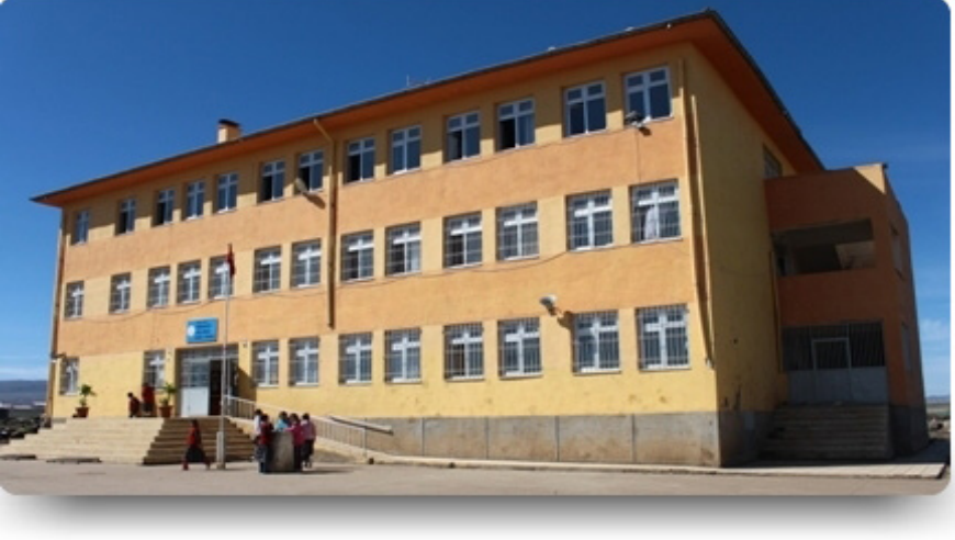
Őekil 5. Okul binası
