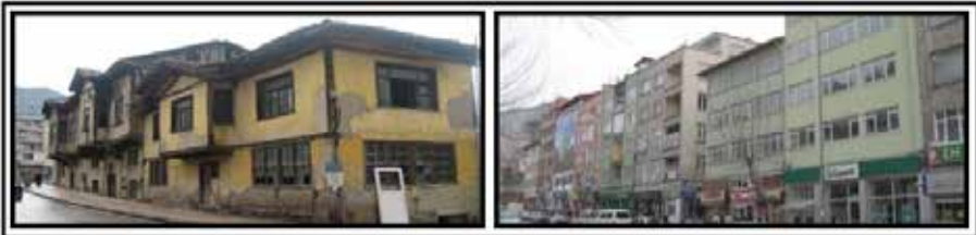
Fotoğraf 4: Amasya'da farklı yapı malzemeleri ile inşa edilmiş yapılara örnekler (Eren SENOL-2009).
