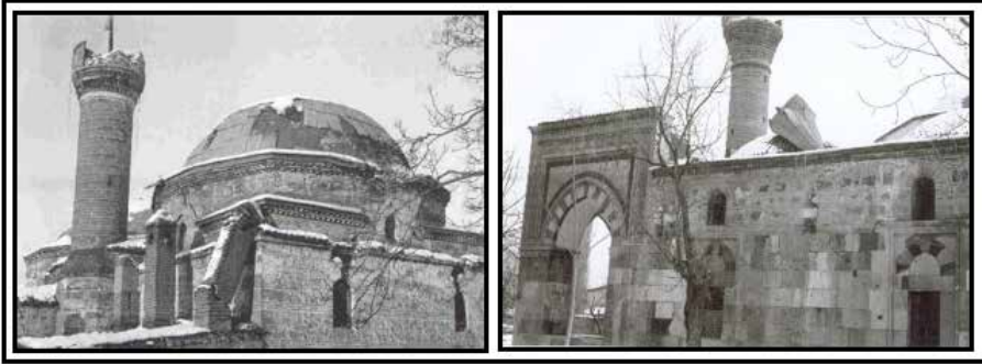
Fotoğraf 1: 27 Aralık 1939 gecesi meydana gelen ve tarihe “Erzincan Depremi” diye kaydedilen depreme zarar gören anıtsal yapılardan ikisi: Çilehane (Solda) ve Bayezid Paşa (Sağda) Cami (Arşiv- Amasya Belediyesi)
