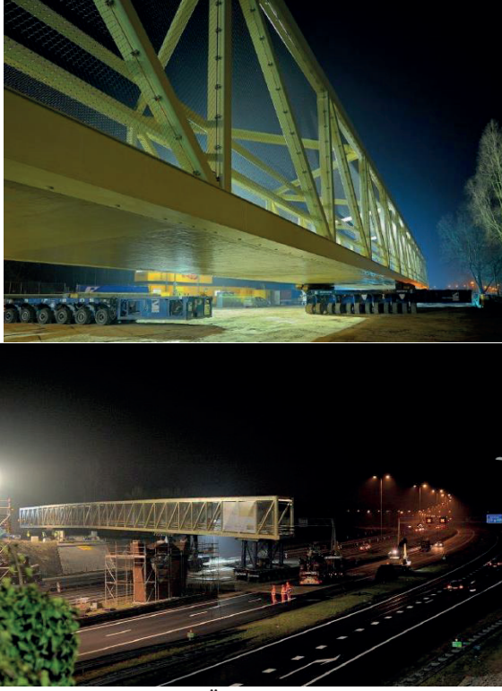
Şekil 14. Utrecht A27 Otoyolu Üzerindeki Hibrit Köprü yapım aşaması – Hollanda (URL-10)
