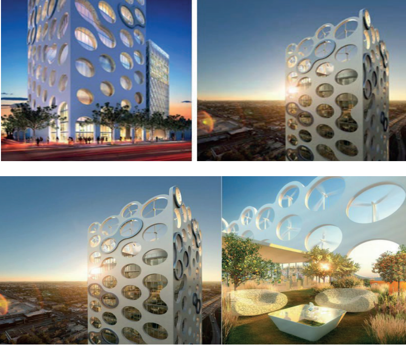
Şekil 1. Miami'deki Cor Binası [8].
