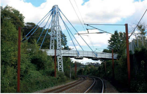
Şekil 11. Fiberline Köprüsü – Danimarka (URL-7)
