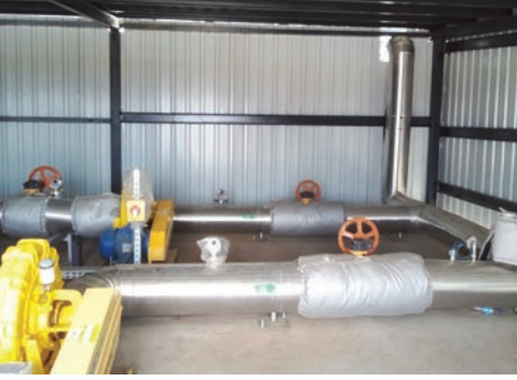
Resim 5. Kojenerasyon Ünitesi(Blower)(Şarkışla Biyogaz Tesisi,2021)
