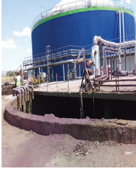
Resim2. Gübre Havuzu (Şarkışla Biyogaz Tesisi, 2021)
