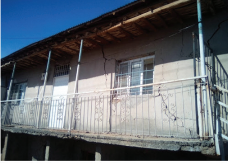
Şekil 19. Farklı zemin oturmalarına bağlı yapısal hasarlar
