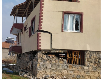
Şekil 19. Farklı zemin oturmalarına bağlı yapısal hasarlar
