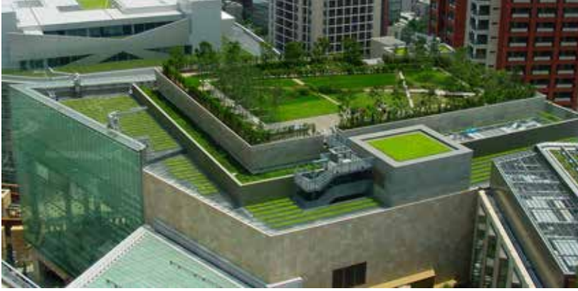
Şekil 9 . Yeşil çatı uygulama örneği (URL-1)
