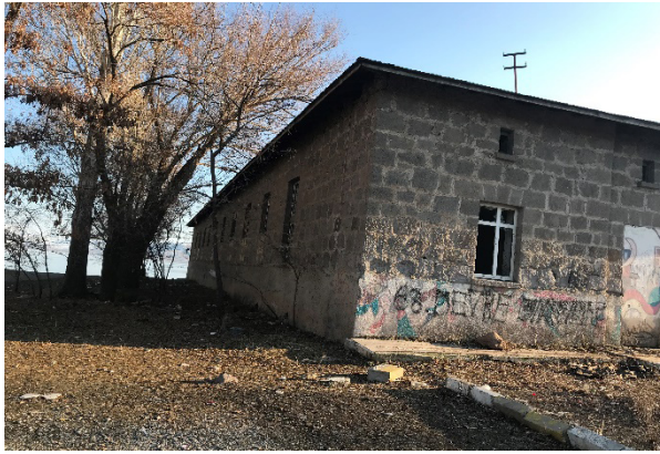
Şekil 11: Van Ernis Köy Enstitüsü Çok Amaçlı Salon Giriş Cephesi
