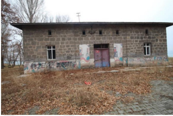
Şekil 10: Van Ernis Köy Enstitüsü Çok Amaçlı Salon Giriş Cephesi
