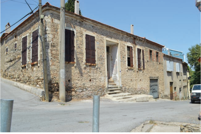
Resim 7. 5311 parseldeki ev (Sakarya Cad. no 8) – Savran Evi
