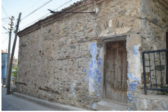
Resim 24. Bakır Evi sokak cephesi
