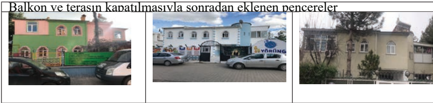
Şekil 18. Balkon ve terasın kapatılmasıyla sonradan eklenen pencereler
