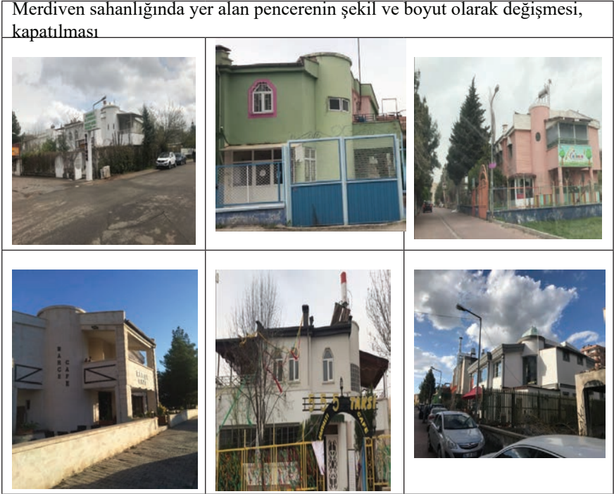
Şekil 16. Merdiven sahanlığında yer alan pencerenin şekil ve boyut olarak değişmesi, kapatılması
