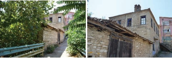
Resim 21-22. Bakır Evi Sokak Cephesi
