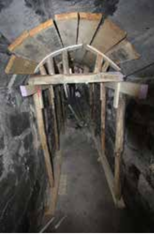
Fotoğraf:25- Tünelde Yapılan Askılama Çalışmaları.
