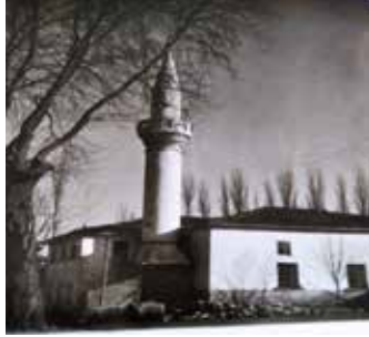
Fotoğraf-7. Kilise kalıntıları üzerine inşa edilen camii 5 1981 Yılında yıkılarak yerine daha büyük bir cami inşa edilmiştir.
