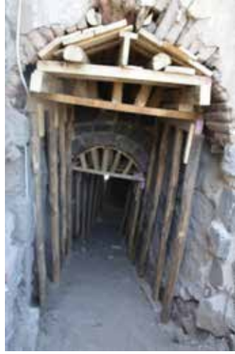
Fotoğraf:25- Tünelde Yapılan Askılama Çalışmaları.
