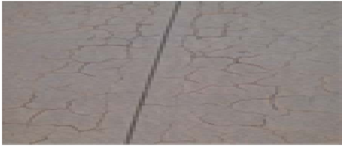
Şekil.1 İzmir Adnan Menderes Havalimanı değiştirilen pist ve taksi yolu betonu [4]
