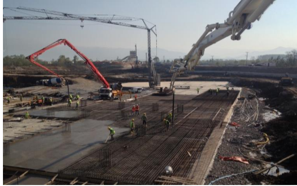
Resim 3. Kocaeli Symbol Alışveriş Merkezi temel inşaatından görünüm (URL-4).
